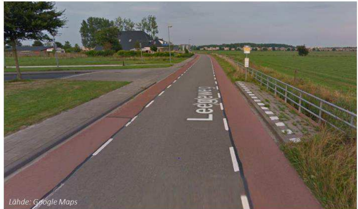
Kuva 24. Esimerkki suosituspyöräkaistoista bussipysäkin kohdalla Hollannissa. (Google Maps)
